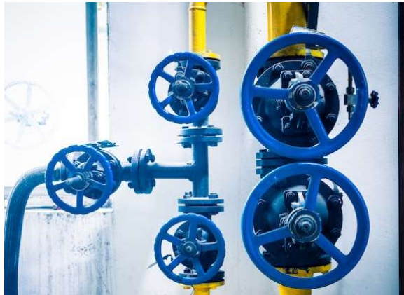
Ouvrir/fermer la mauvaise valve
